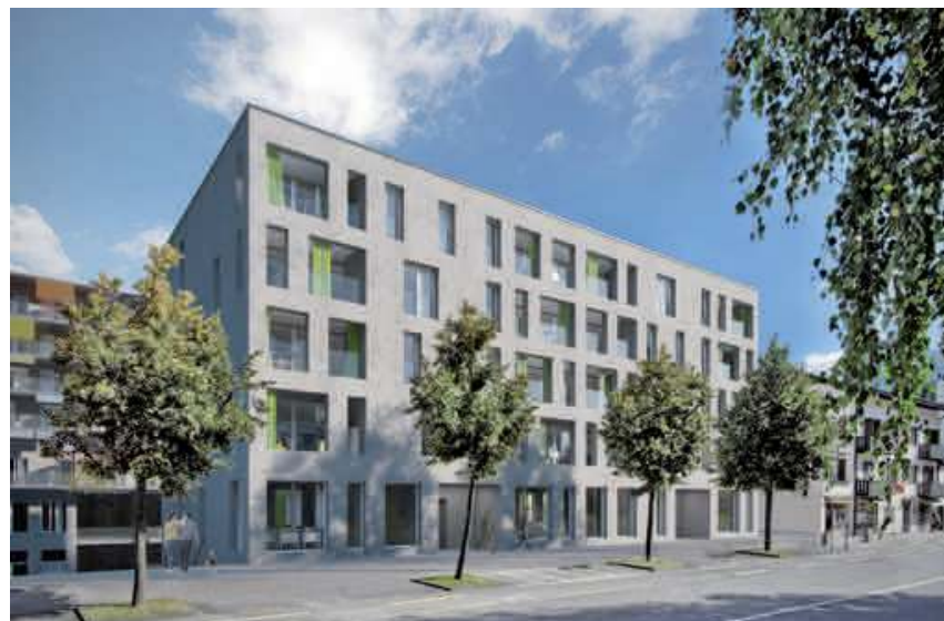
Vue de la Route du Jura sur l'immeuble 41
